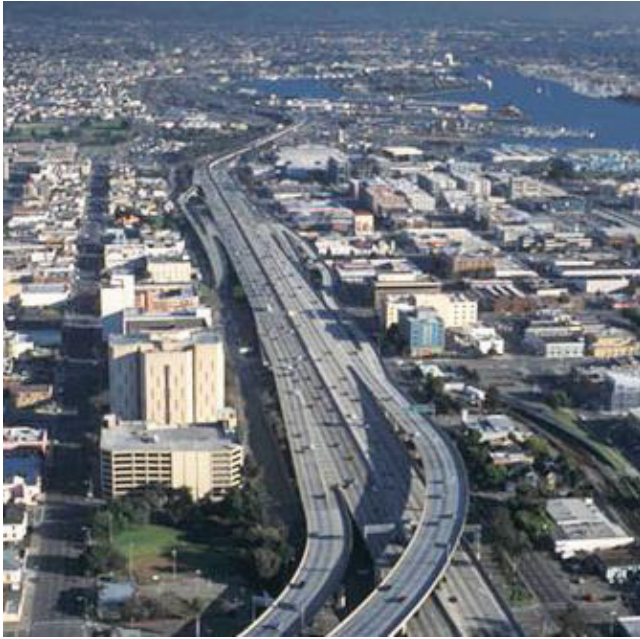
Vista aérea del Proyecto de Acceso a la Oakland Alameda.
