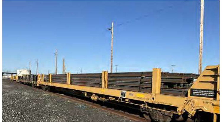
新的轨道正在运往施工现场。
