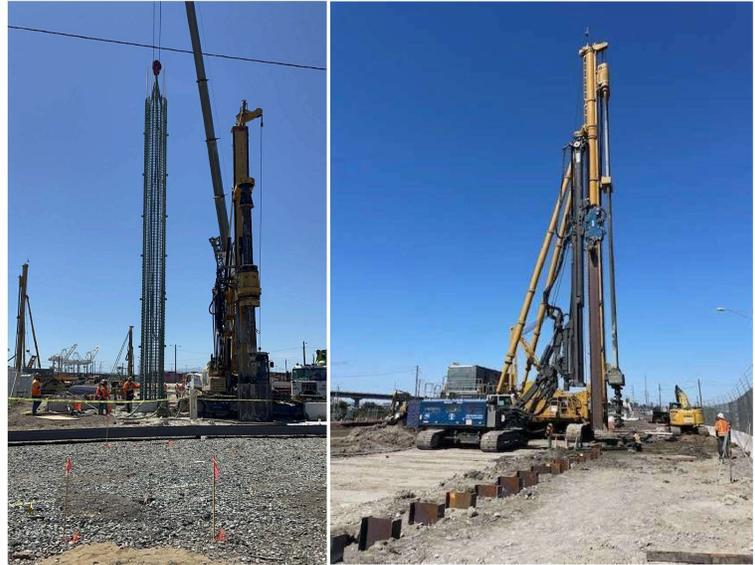
(左圖)加固鋼筋籠的安裝和為新道路和新橋墩的挖掘工作而準備的鋼樑板樁的安裝(右圖)
