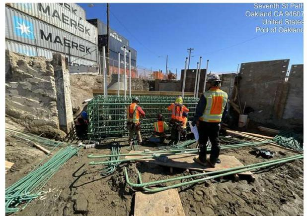
在新橋上的金德爾摩根公司(Kinder Morgan)油管綫路的鋼筋加固安裝
