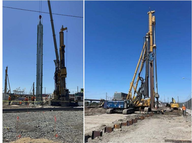
(Derecha) Instalación de jaula de refuerzo de acero y a la (Izquierda), vigas de acero son enterradas en preparación para la excavación de la nueva carretera y puente
